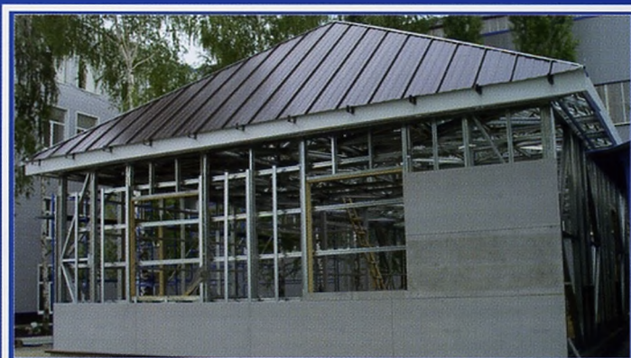
Фальцевая кровля и обшивка "Аква Панелями"
