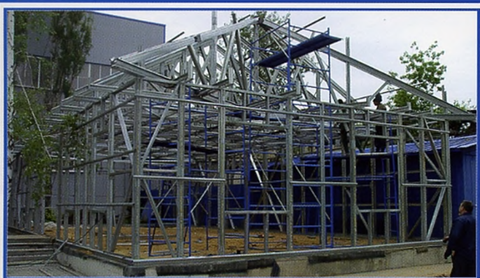
Каркас здания и стропильная система
