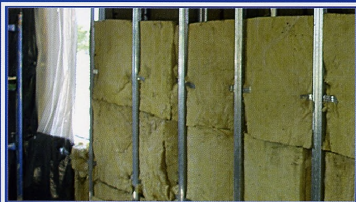
Обшивка утеплителем URSA П-30
