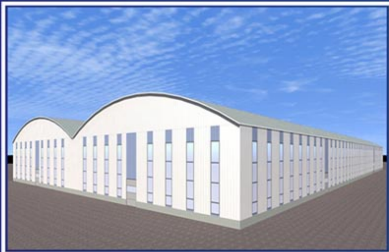
Бескаркасное здание типа Эксергия 60x185x12(н)м
